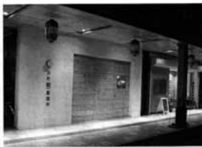
前面部のみの改装により古い店舗を活用
