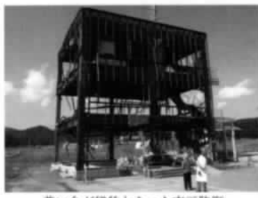
尊い命が犠牲となった南三陸町「防災対策庁舎」
